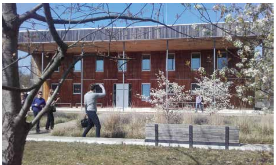
HAUS 2019, az Év Háza Marienfeldeben, mely akadálymentes, zéró energiaigényű, könnyűszerkezetes irodaház.
