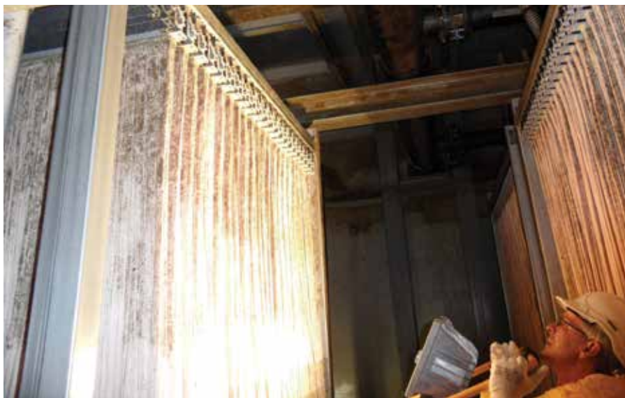
Már használatban lévő membránok helyszíni ellenőrzése
